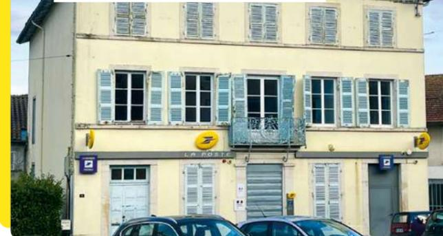
Réfection de l'intégralité de la toiture et des chéneaux, isolation par l'extérieur ainsi que le remplacement de toutes les fenêtres et volets du logement situé à l'étage, voici les grandes lignes de ce chantier qui débutera au printemps pour se terminer avant la fin d'année.
